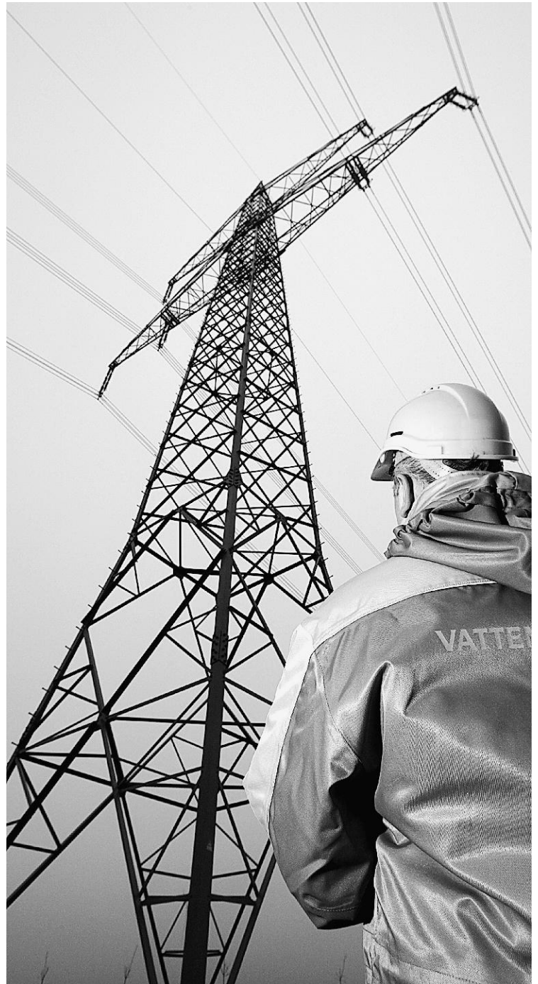
Ein Vattenfall-Baukontrolleur steht an einem Strommast der Südwestkuppelleitung des Energiekonzerns bei Steigra (Sachsen-Anhalt). Die 380-Kilovolt-Leitung soll 210 Kilometer von Halle nach Erfurt und dann über den Kamm des Thüringer Waldes bis nach Schweinfurt in Franken reichen. Archivfoto: dpa
