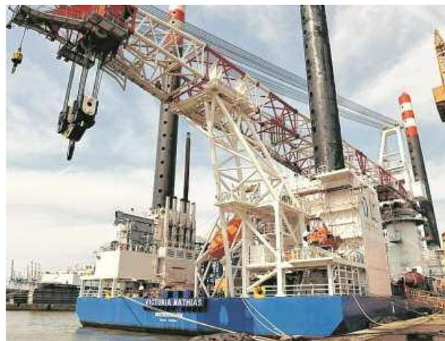
Energiewende vor der Küste: Das Installationsschiff Victoria Mathias soll den Windpark „Nordsee Ost“ aufbauen helfen, der 30 Kilometer nördlich von Helgoland errichtet wird.
